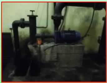
El surtidor existente tiene una dotación de caudal de 15 litros x segundo.
